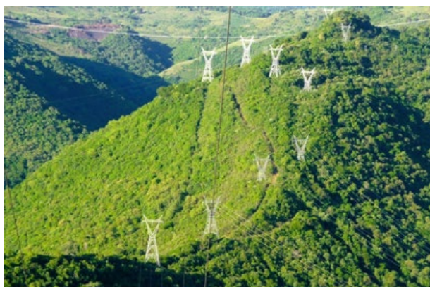
Figura 1.3. Las líneas eléctricas forman parte de los paisajes actuales. Se estima que hay más de 70 millones de km de líneas eléctricas en uso en todo el mundo; para 2025 se espera que la red haya superado los 166 millones. Paisaje atravesado por tendidos, Brasil. © Mozart da Silva Lauxen / IBAMA
