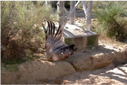
Figura 3.10. Algunos estudios han puesto de manifiesto que la mortalidad en tendidos eléctricos es el principal problema de conservación de ciertas especies en estado de conservación desfavorable, como es el caso del águila imperial ibérica ( Aquila adalberti ) en España. Juvenil de la especie electrocutado al pie de un poste. © Justo Martín
