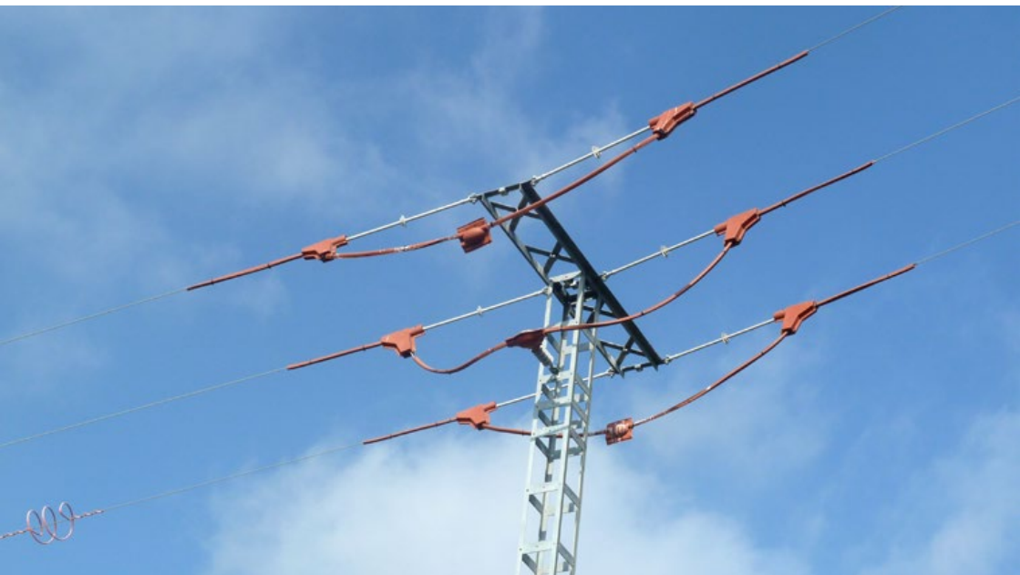
Figura 1.11. Existe la capacidad científica, de ingeniería e industrial para implementar medidas efectivas de prevención y mitigación. Poste adaptado con dispositivos de alejamiento (aisladores largos) y aislamiento (fundas de conductores, grapas y puentes). © Justo Martín
