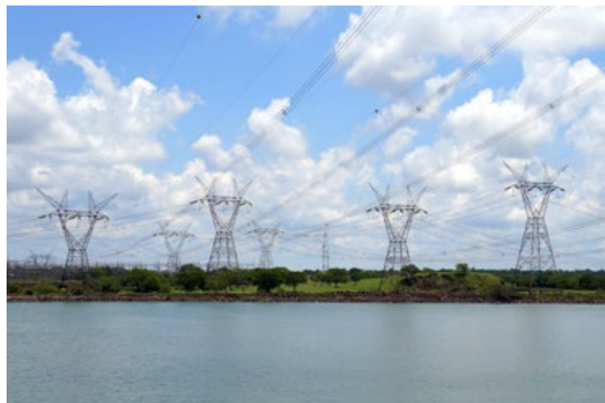
Figura 5.3. En zonas con alta densidad de líneas eléctricas, con muchos planos de cables horizontales, el riesgo de colisión es importante. Líneas de transmisión asociadas a la presa de Itaipú, en Paraguay. Por Leandro Neuman vía Wikimedia Commons. CC BY 2.0
