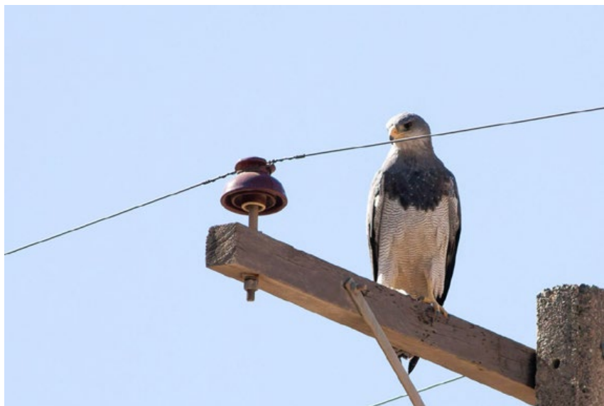
Figura 1.12. Es urgente abordar la adaptación de tendidos eléctricos peligrosos en Latinoamérica para minimizar una de las principales causas de mortalidad que afectan especialmente a rapaces. Águila mora ( Geranoaetus melanoleucus ). Por Ariel Cabrera Foix vía iNaturalist Chile. CC BY-NC
