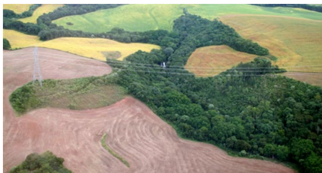
Figura 3.1. Las estructuras de las líneas eléctricas producen un importante impacto visual en el paisaje por el que transcurren. Línea de transmisión Ita-Caixas, Brasil. © Mozart da Silva Lauxen/IBAMA
