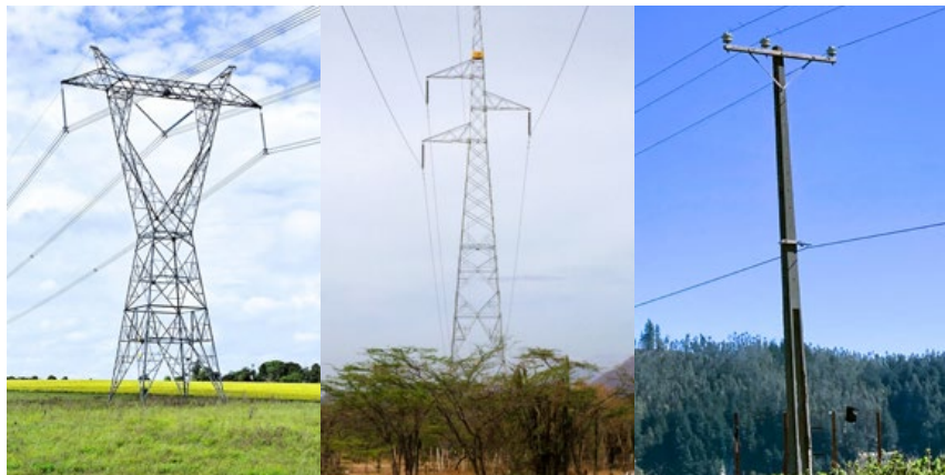
Figura 2.22. Torre de transmisión de muy alta tensión (izquierda) © Pablo G. Fernández; torre de distribución de alta tensión (centro) © Darío Correa; poste de distribución de media tensión (derecha) © Francisco Santander
