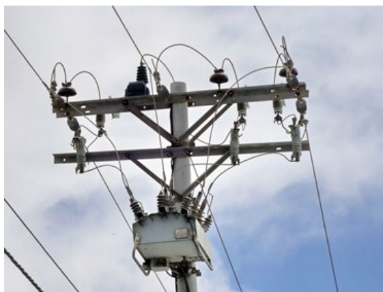
Figura 2.21. Poste con interruptor-seccionador montado en el fuste. © Justo Martín
