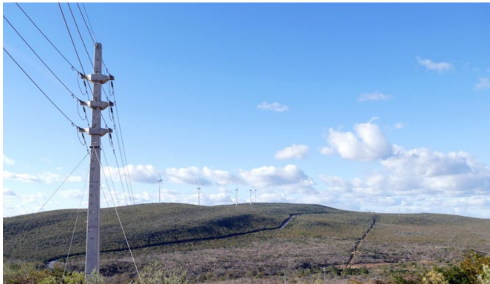
Figura 8.12. El desarrollo de las energías renovables requiere la construcción de nuevas líneas eléctricas. Planta eólica, al fondo de la imagen, con líneas eléctricas asociadas, Brasil. © Álvaro Camiña
