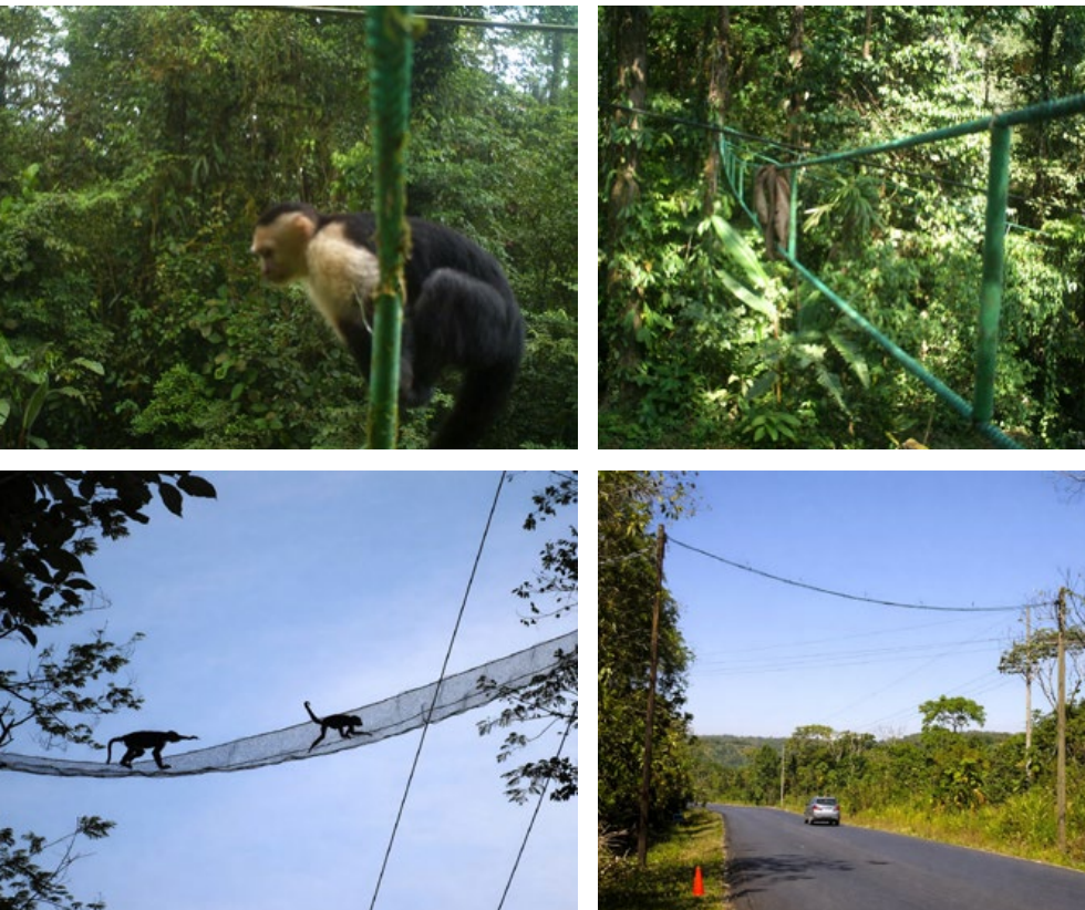
Figura C.12. De izquierda a derecha y de arriba a abajo: puente aéreo con una sola cuerda; diseño con dos cuerdas; puente tipo “hamaca”; puente sobre una carretera. © CNFL
