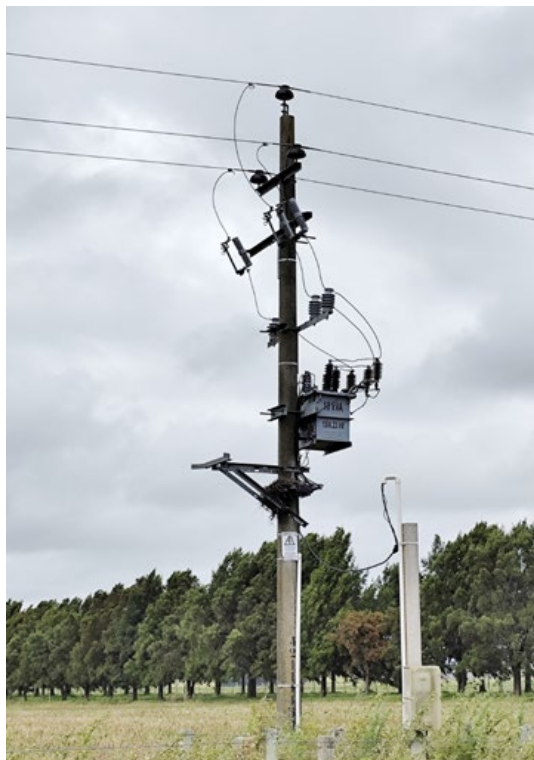
Figura i.5. Este manual tiene entre sus objetivos servir de herramienta para la caracterización y evaluación de la peligrosidad de los diferentes tipos de líneas eléctricas más frecuentes en Latinoamérica. Línea eléctrica en Uruguay. © Pablo García Fernández
