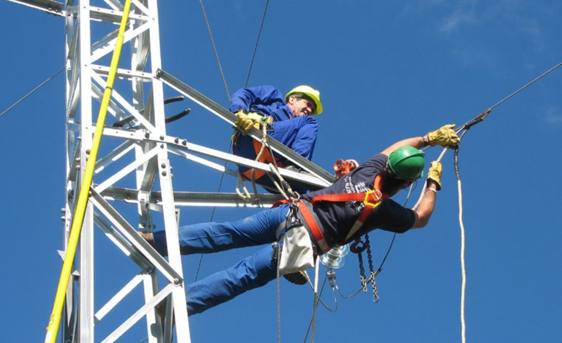
Figura 8.1. La preparación e implementación de planes de acción específicos ayudarán a resolver el problema de las interacciones negativas entre la fauna y las líneas eléctricas. Operarios instalando sistemas antielectrocución, España. © Justo Martín
