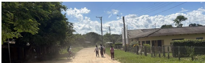
Figura 4.13. Las líneas eléctricas situadas cerca de poblaciones, carreteras o vías de transporte suelen ser menos frecuentadas por las aves, en particular por las especies más sensibles a la presencia humana. Líneas eléctricas que transcurren cerca de una vía de comunicación y entre viviendas, Colombia. © Isabel Jado
