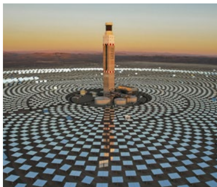
Figura 2.2. En las plantas termosolares la luz del sol se utiliza para calentar unas sales a una temperatura capaz de generar vapor de agua y producir electricidad mediante una turbina. Planta Termosolar Cerro Dominador, desierto de Atacama (Chile), la primera en su género en Sudamérica. Por Tamara Merino/ International Monetary Fund. CC BY-NC-ND
