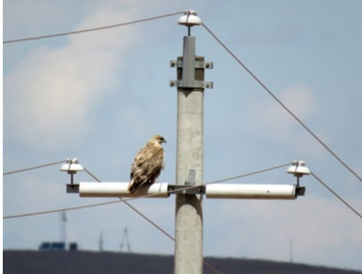
Figura 4.26. En algunas configuraciones, colocar fundas de plástico rígido en la cruceta es una forma sencilla y barata de hacerlas seguras. Ratonero de montaña ( Buteo hemilasius ), Mongolia. © Proyecto Mohamed bin Zayed Raptor Conservation Fund
