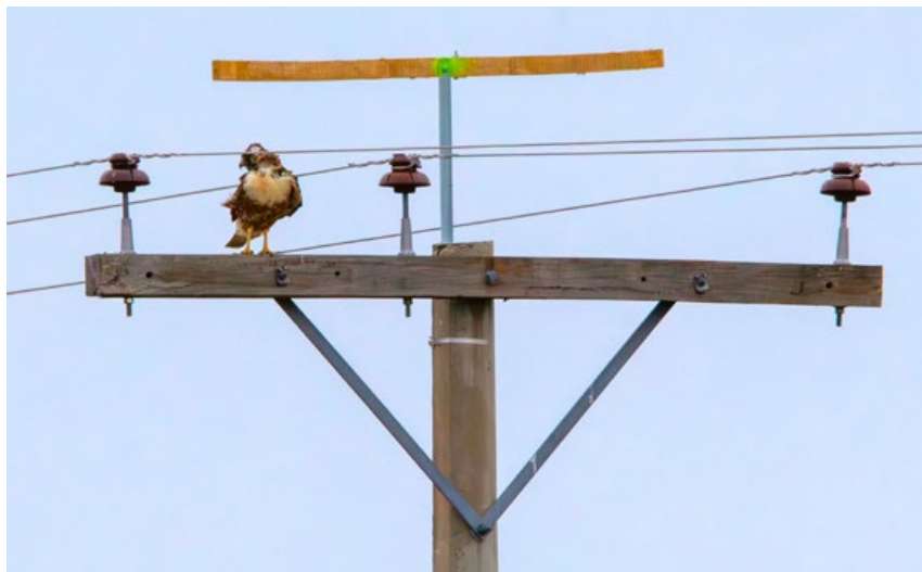
Figura 9.5. El empleo de posaderos o perchas artificiales es una medida totalmente inútil para evitar la electrocución de las aves en líneas eléctricas. A pesar de la abundante información al respecto, y la evidencia empírica que así lo demuestra, estos posaderos han sido establecidos en decenas de kilómetros de líneas eléctricas en la provincia de La Pampa. © Mauricio Flores/CECARA
