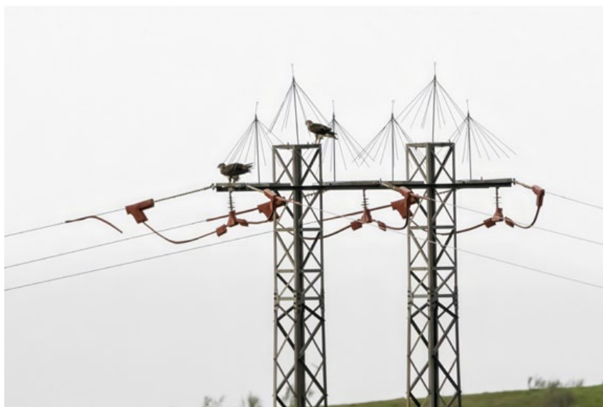
Figura 4.36. A la hora de elegir las medidas, es muy importante evaluar las especies sensibles objetivo, seleccionar buenos materiales y garantizar una instalación adecuada. La imagen muestra cómo los dispositivos anti-posada instalados no impiden que las aves utilicen el poste, y las pone en riesgo de sufrir lesiones; además, una funda de un conductor se ha soltado debido a una instalación defectuosa (España). © Íñigo Fajardo
