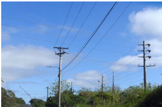
Figura 3.6. La acumulación de tendidos eléctricos en un mismo lugar da lugar a auténticas barreras que pueden interferir los movimientos de la fauna. Zona de concentración de líneas eléctricas en Ecuador. © Álvaro Camiña
