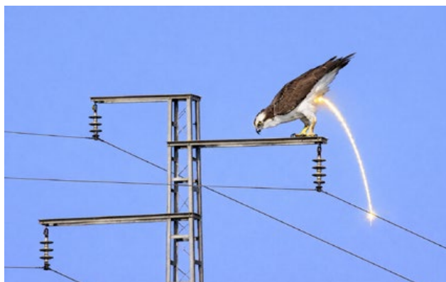
Figura 4.7. La defecación de las grandes aves rapaces en forma de un chorro largo puede provocar electrocuciones cuando el extremo del chorro entra en contacto con un conductor debajo de una cruceta de metal. © Justo Martín. Imagen generada por IA.
