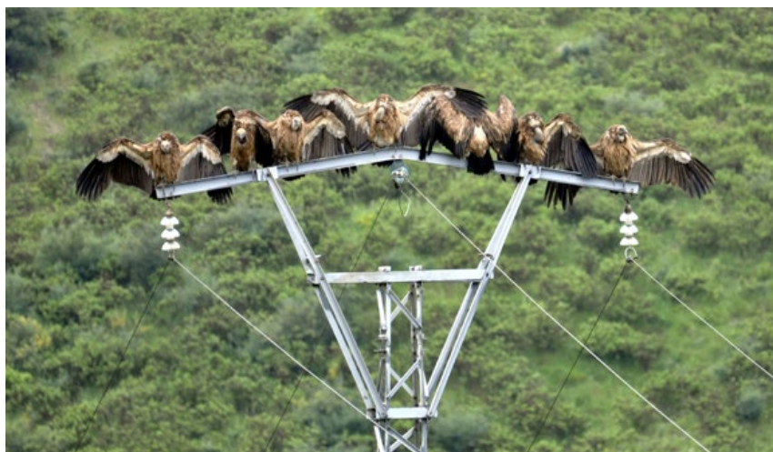
Figura 4.5. Cuando se posan varios ejemplares en un mismo soporte pueden producirse electrocuciones grupales por el contacto entre los diferentes individuos. Buitres leonados ( Gyps fulvus ) secándose el plumaje tras una lluvia en el norte de Marruecos; en este caso no hay riesgo por el diseño de la cruceta, pero si ésta tuviese un diseño no seguro para las aves, el riesgo de electrocución múltiple sería muy elevado por el estrecho contacto y el plumaje mojado. © Rachid El Khamlichi
