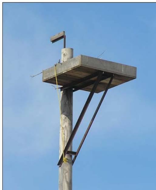
FIGURA 6.14: Una plataforma de anidación saliente, simple y de bajo costo, construida para las águilas pescadoras en Washington. Los palets pueden usarse como plataformas, proporcionando a las águilas pescadoras un área de anidación llana.
