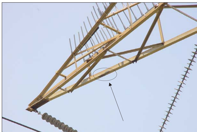
FIGURA 6.29: Marcas de quemaduras en estructuras de transmisión asociadas con arco eléctrico provocado por excretas.
