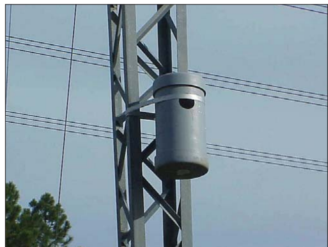
FIGURA 6.20 Tubo de anidación de cernícalo (longitud 46 cm [18 in]) instalado en una torre de transmisión en Georgia.
