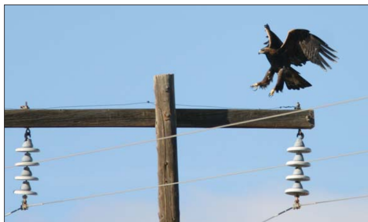
FIGURA 2.2: Águila real aterrizando en poste seguro para aves. Las investigaciones iniciales sobre electrocuciones de aves y modificaciones de postes se enfocaron mayormente en las águilas reales.
