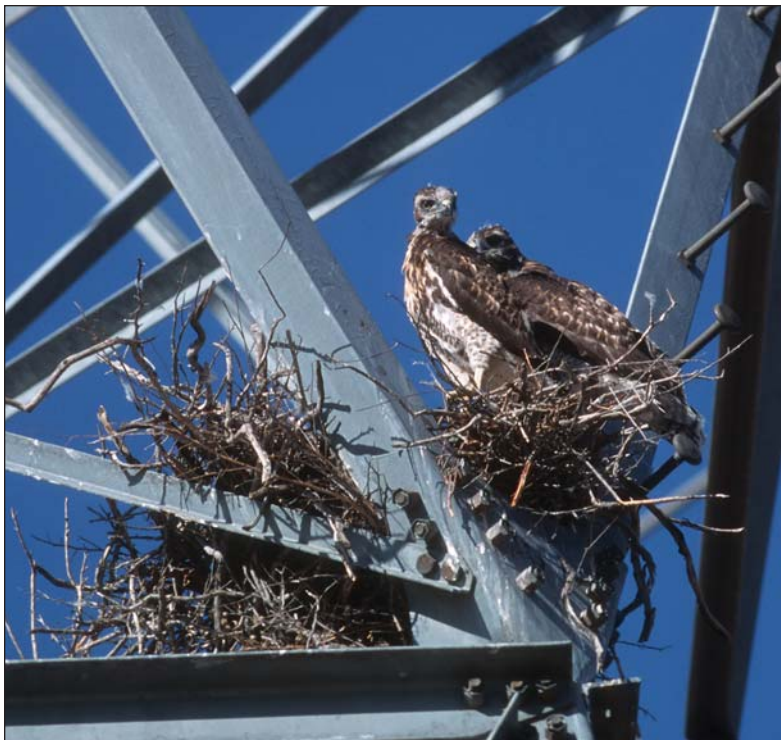
FIGURA 6.3: Nido de aguijilla cola roja en una escalera de acero de una torre de transmisión.
