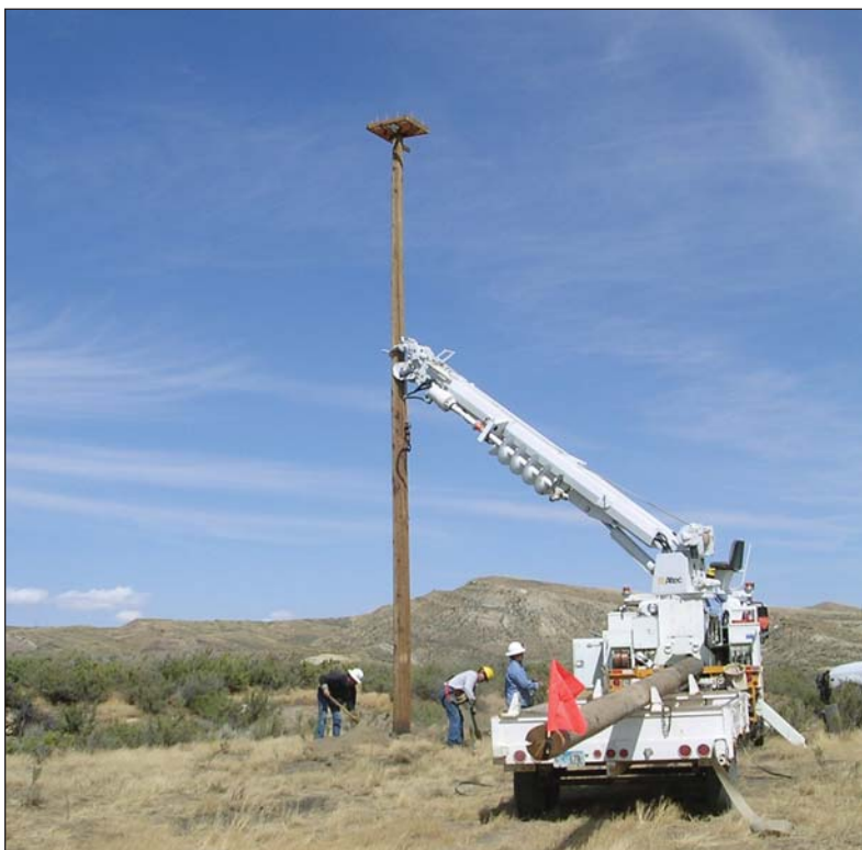
FIGURE 7.1: Personal de la compañía eléctrica instalando una plataforma de anidación para rapaces.
