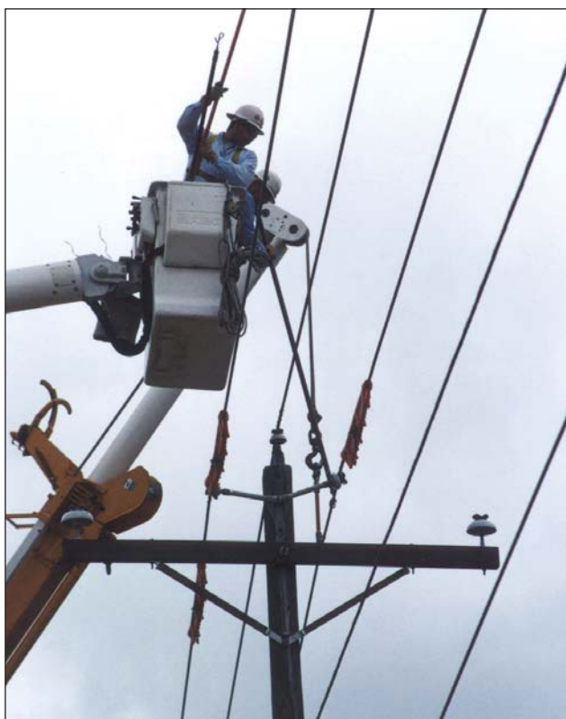
FIGURA 7.2: Reestructuración de una cruceta para prevenir la electrocución de aves.
