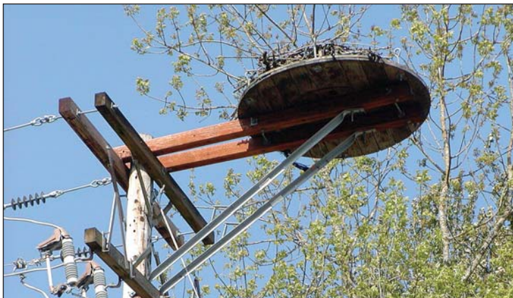
FIGURA 6.10: Diseño de plataforma de anidación para águila pescadora desarrollada por Portland General Electric. La plataforma es construida con el fondo de un carrete de madera para cable de 1.5 metros (m) (5 pies [ft]) de diámetro con un cable forrado en el borde para contener el material del nido. Las compañías de electricidad deben asegurar que las partes y equipamiento energizados bajo el nido están cubiertos para prevenir la electrocución de aves o interrupciones eléctricas provocados por el material del nido. La Consumer's Power, Inc. modificó este poste según los estándares seguros para aves.
