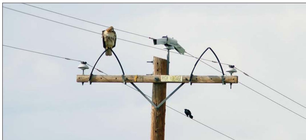
FIGURA 2.5: Dispositivos desalentadores de perchado se han instalado en los postes eléctricos para prevenir que las rapaces o los córvidos tomen presas de especies sensibles. Sin embargo, esto no se recomienda, ya que los desalentadores de perchado tienen por objetivo influir sobre dónde se posan las aves, no evitarlo completamente.
