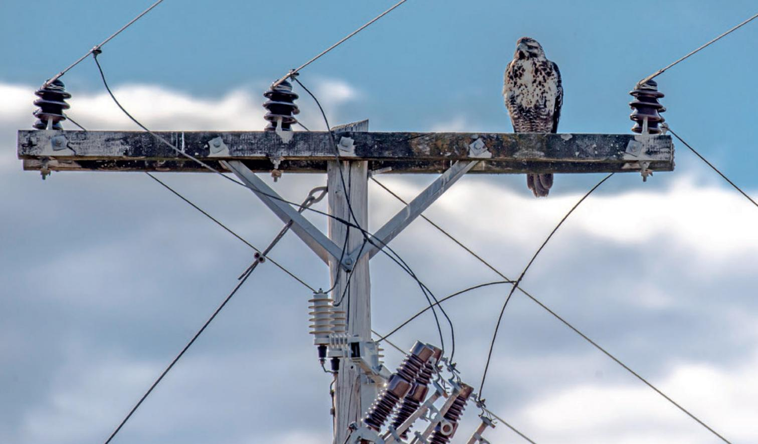
▲ **Juvenil de águila mora** posada en una cruceta de un poste de línea de distribución. Los aisladores rígidos en forma vertical y el cableado hacia los interruptores en la parte inferior, aumentan la probabilidad de contacto del ave con dos de las fases o cables en forma simultánea, posibilitando así su electrocución.
